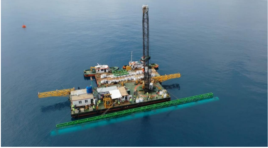
Resim 4: İlk DN 2000mm difüzör hattının yerleştirilmesi (8)
